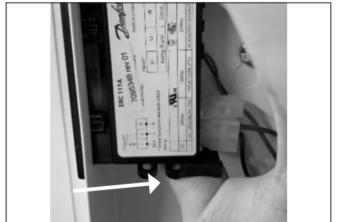
5: Utilice el dedo para presionar y deslizar la abrazadera inferior hacia atrás para retirarla del cuerpo del termostato
