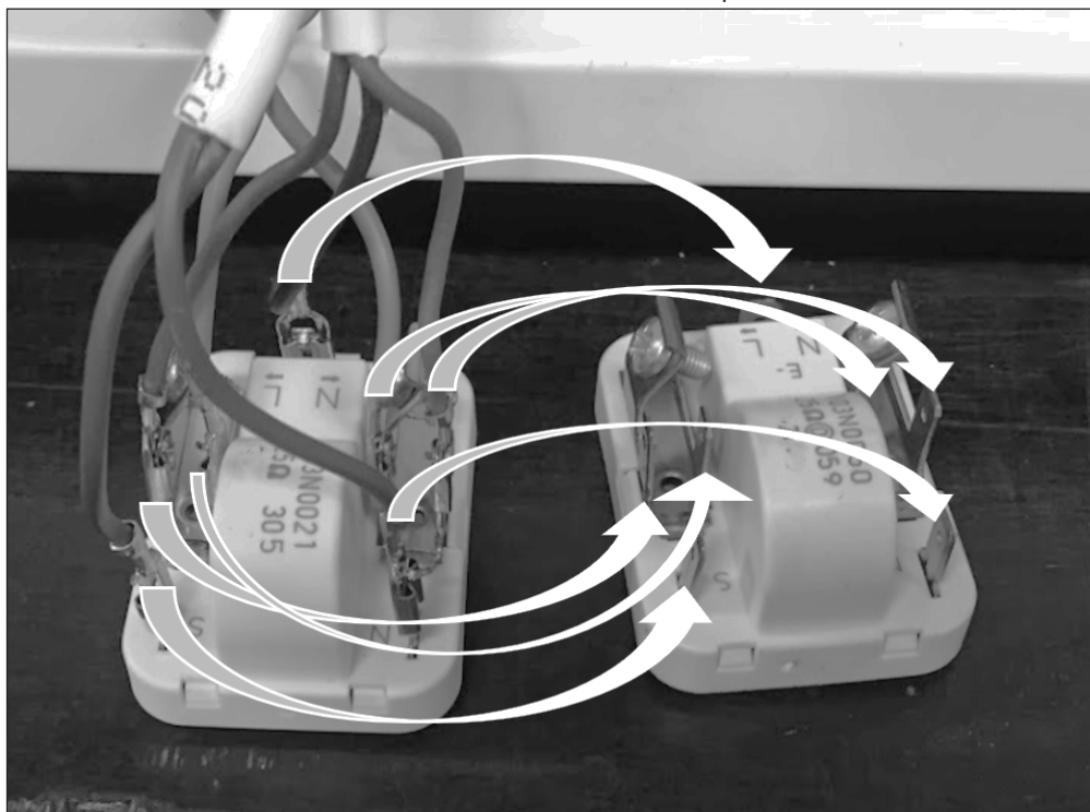
9. Cambie los cables 1/1 del dispositivo de arranque antiguo al nuevo.
